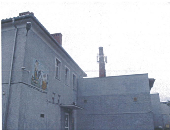
Zat. nr 1: Widok ogólny instalacji radiokomunikacyjnej.
