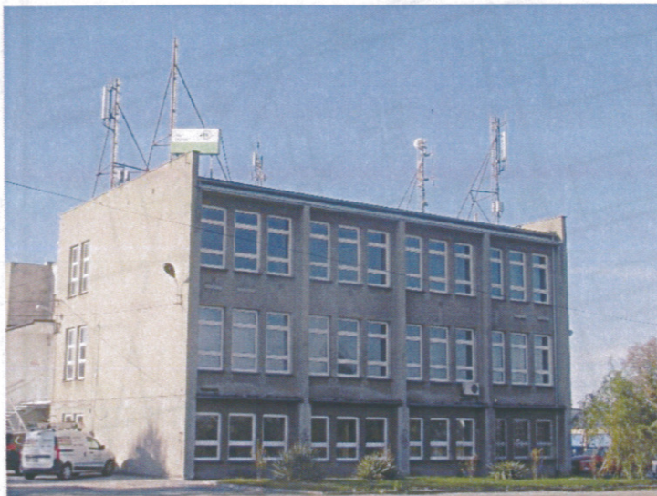
Zał. nr 1: Widok ogólny instalacji radiokomunikacyjnej.
