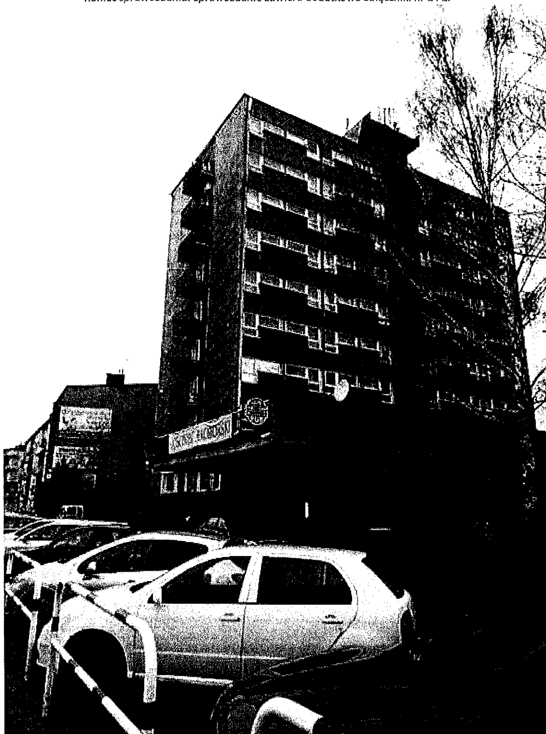
Zał. nr 1: Widok ogólny instalacji radiokomunikacyjnej.
