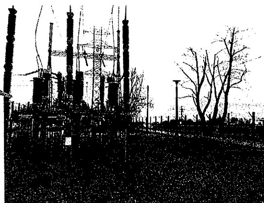
Widok na stację 110 kV – w tle ciąg spacerowy nad Odrą
