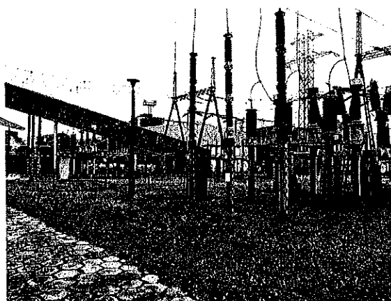
Widok na stację 110 kV – wewnątrz
